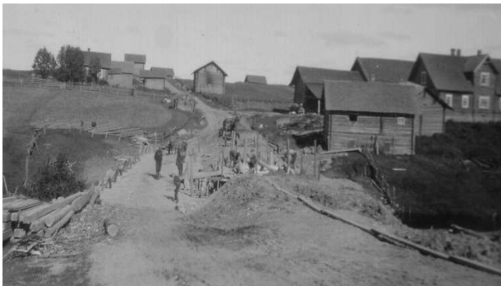
Varpaelän siltaa rakennetaan.
